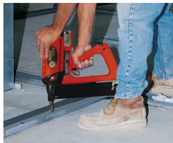
Rail sur béton
