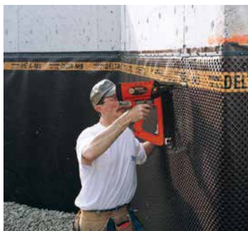
Imperméabilisation du béton
