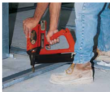
Rail sur béton
