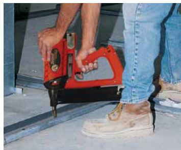
Rail sur béton
